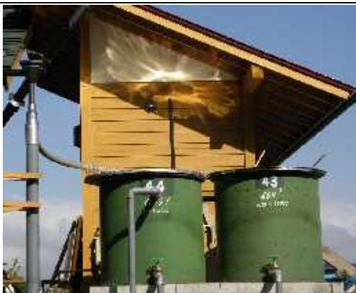
＜雨水利用施設＞2007年設置 ・ホロータンク容量・・・2基約1300ℓ ・ドイツ製雨水集水器取り付け
