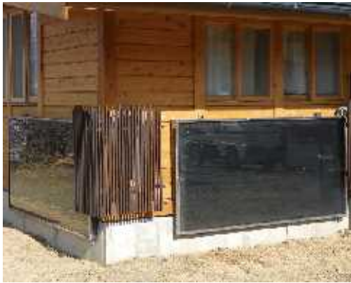
＜ヒートウォール＞2011年設置 ・太陽熱温水器中古パネル2枚 （南向きと西向き） ・室内温度センサー付、冬期使用
