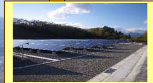
メガワットソーラー発電施設(環境ツアー)
