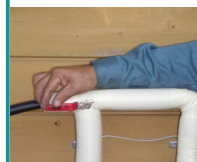
ボイラーから給湯
